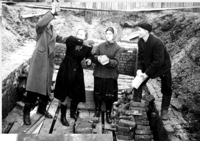
Фото 03.14. На строительстве теплицы.
