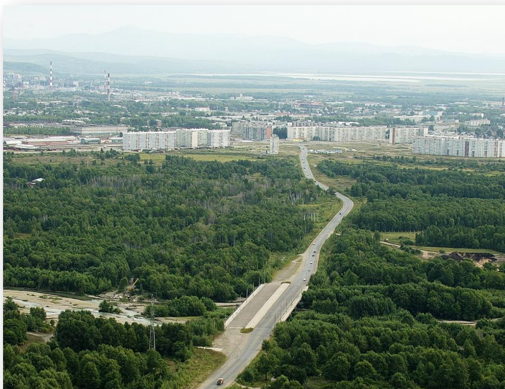
Фото 14.17. Мост улицы Лазо через Силинку.
