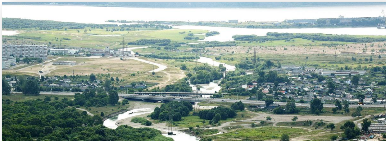
Фото 12.08. Панорама строительства завода «Парус». Справа намытое желтое пятно – место для размещения завода по генплану. Слева – фактическое размещение завода.
